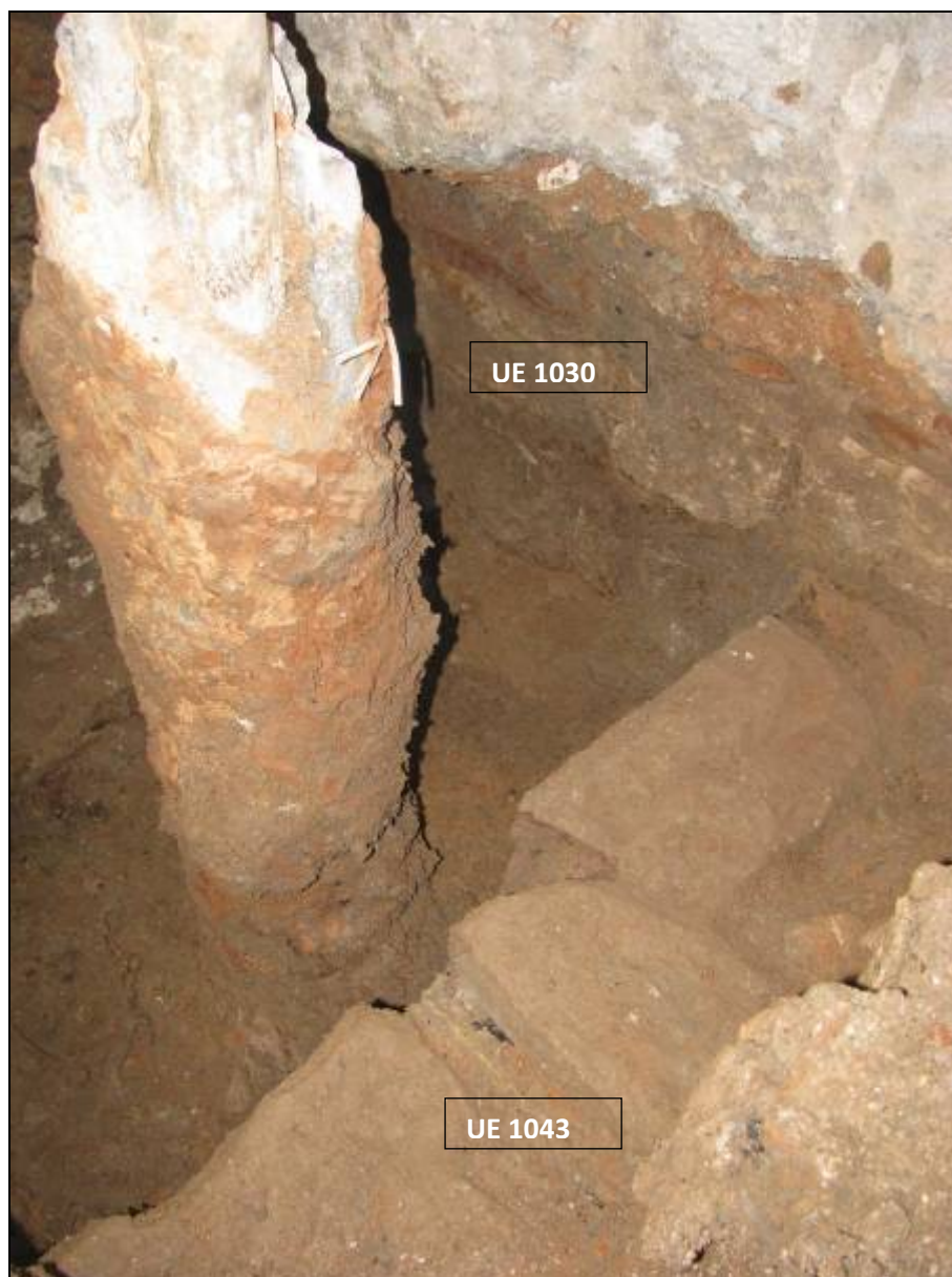
Foto 25. Encepat 19. Afectació sobre la fossa sèptica UE 1043 i el mur UE 1030.
