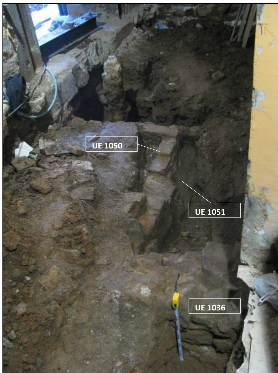
Foto 28. Afectació per la rasa 1 de les estructures UE 1050, UE 1051 i UE 1036.
