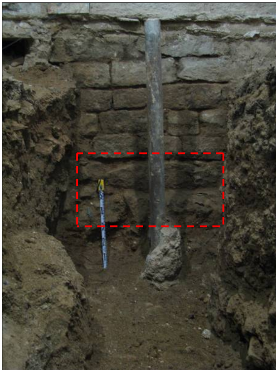
Foto 15. Mur UE 1017. Afectat per l'encepat 6.
