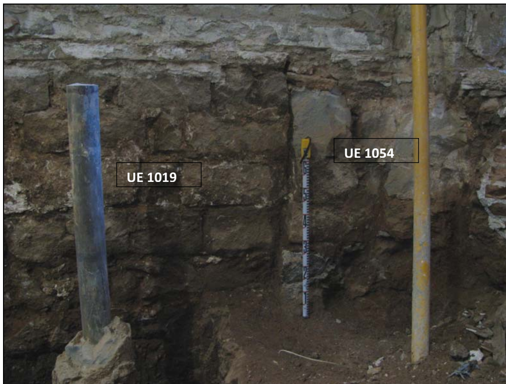
Mur UE 1019 recolzant-se en estructura UE 1054.
