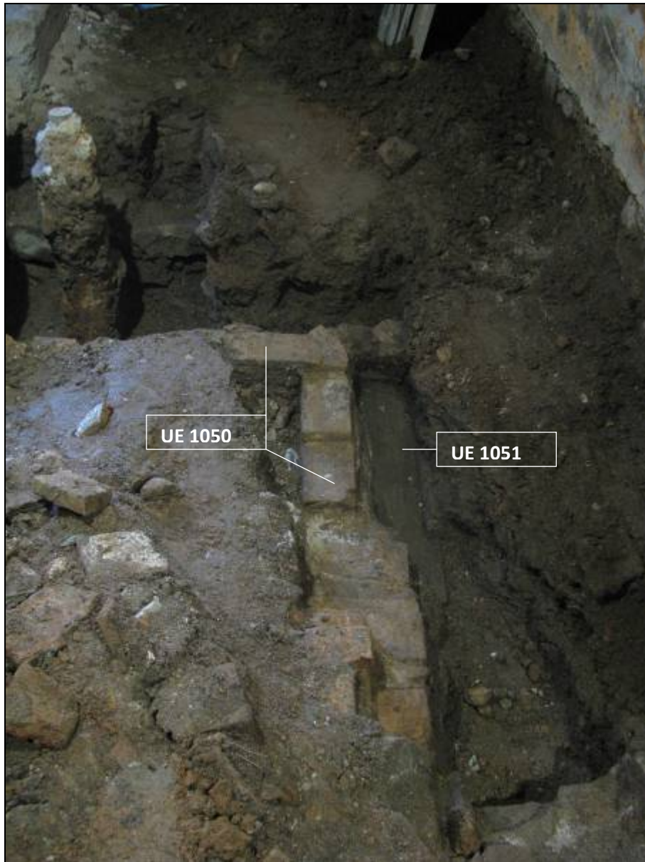
Foto 27. Afectació per la rasa 1 de les estructures UE 1050 i UE 1051.
