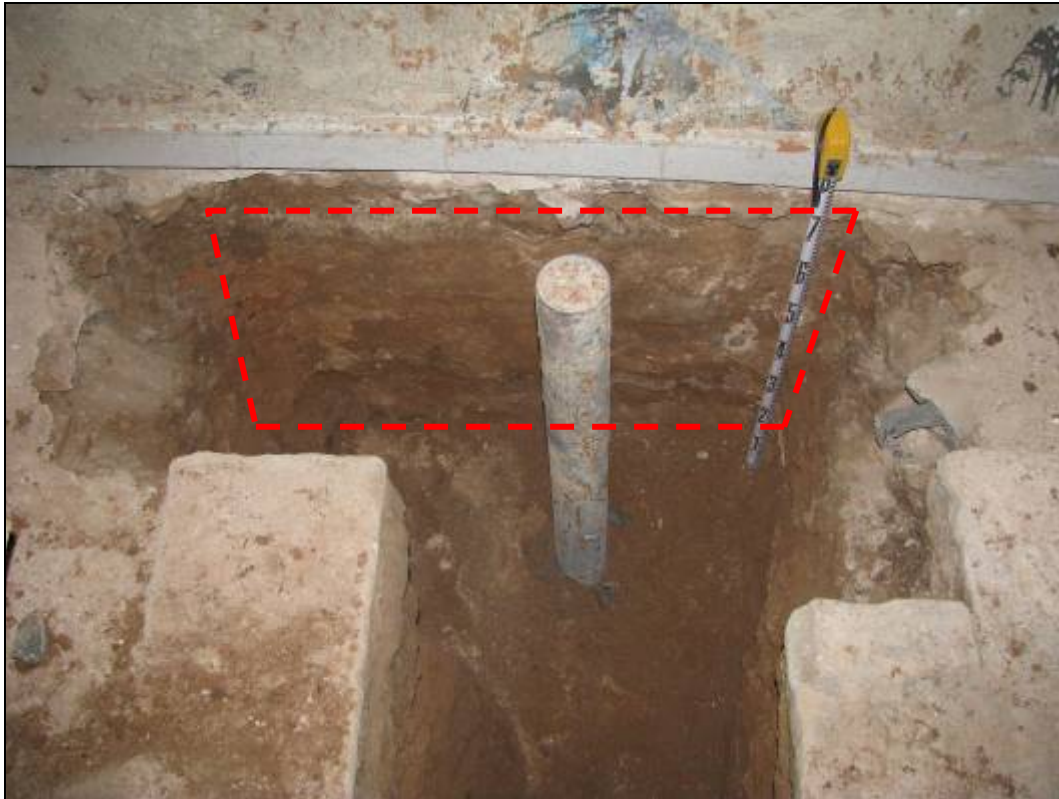
Foto 9. Mur UE 1023. Afectat per l'encepat 1.
