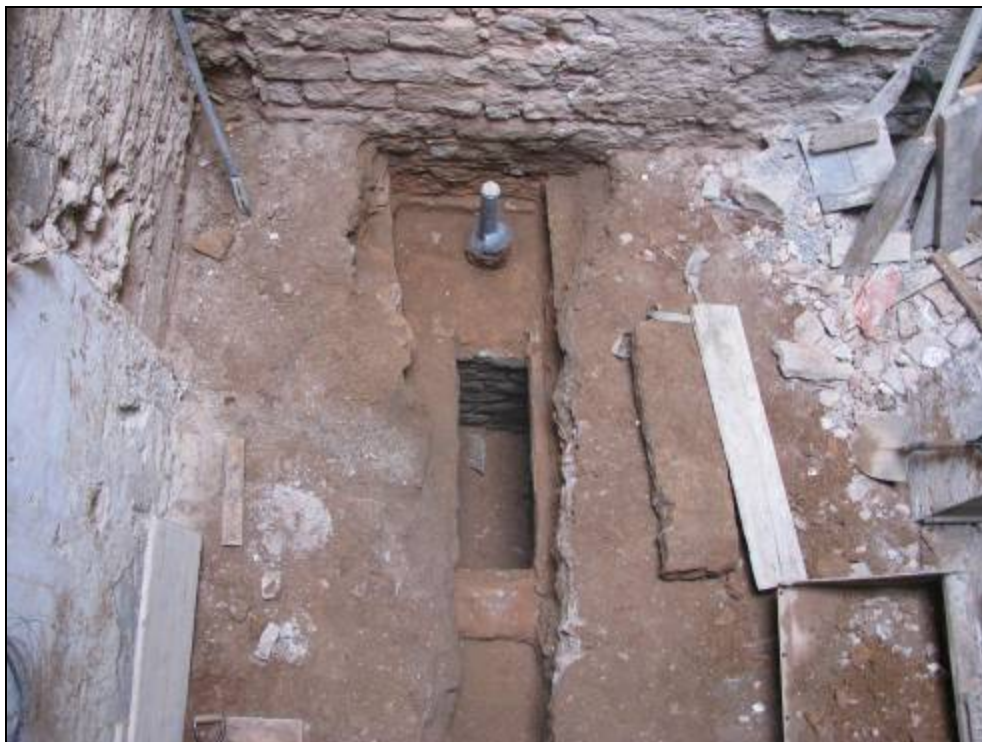
Foto 14. Vista conjunta del mur UE 1017 i la fossa sèptica UE 1025.
