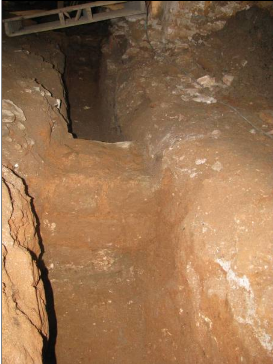
Foto 32. Afectació per la rasa 1 del mur UE 1041.
