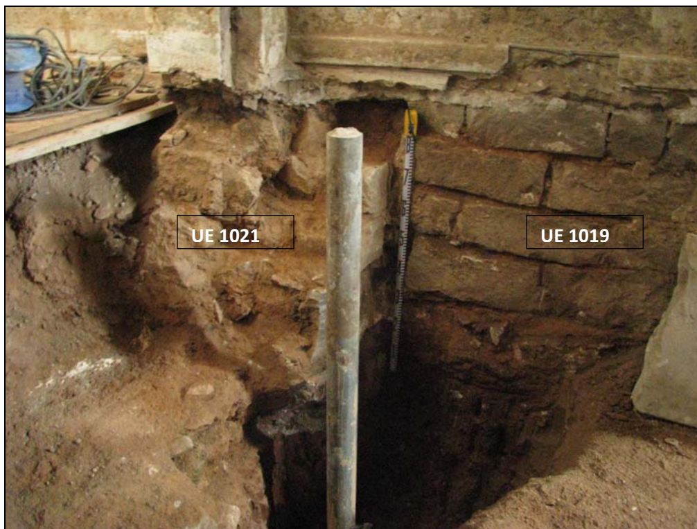
Mur UE 1019 recolzant-se en estructura UE 1021.
